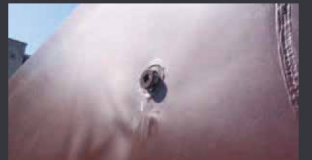
Musluk ile açıklığın kapatılması. Bir sonraki odaya geçilir.
