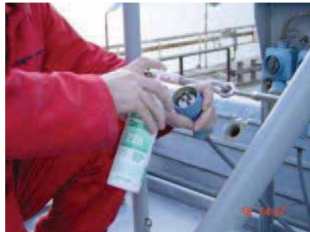
18.b Elektrik kontaklarının korunması için VpCI® 238 uygulaması
