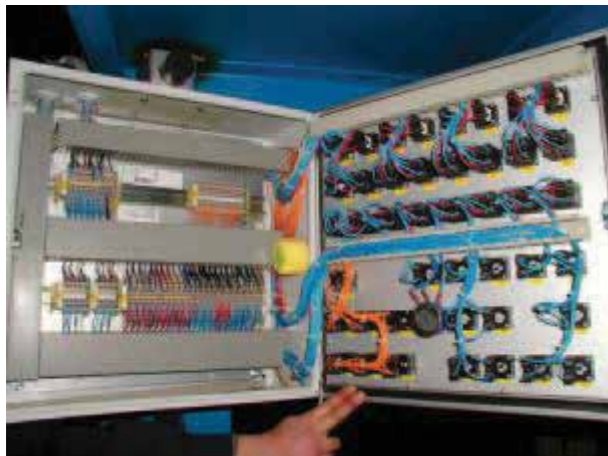
18.a VpCI® Vericin'in elektrik panosuna uygulanması
