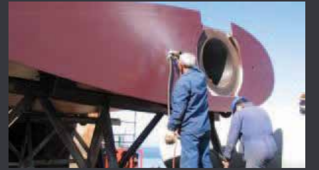
Korozyon önleyici, açıklıklardan dümene üflenir.
